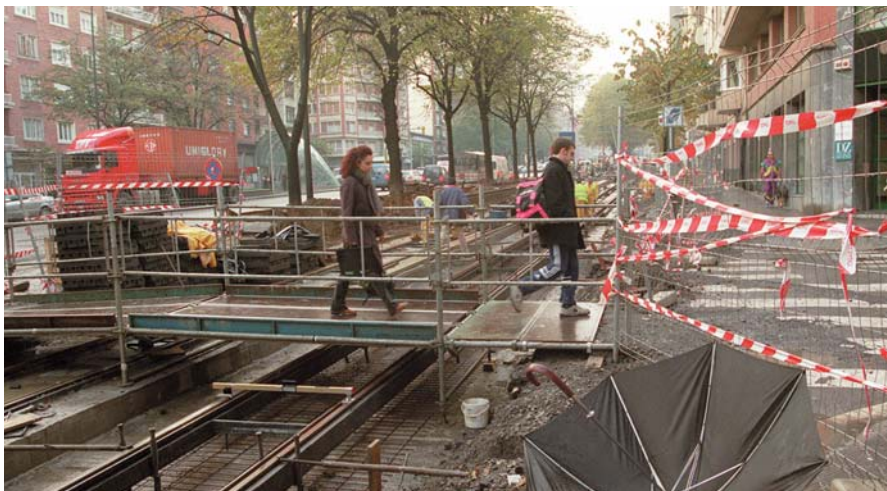
Obras en Bilbao
